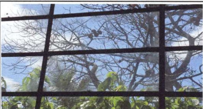
Foto 3: MÓDULO 1 AULAS VENTANAS: Sustrucción de vidrios
