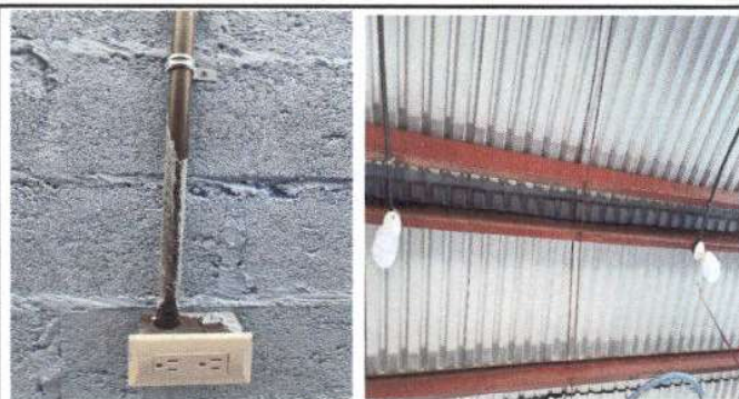
Foto 4: MÓDULO 1 AULAS REPARACIÓN DE SISTEMA ELÉCTRICO: Sustrucción de tomacorrientes dobles; Sustrucción de tablero de flípones; Reparación de cableado eléctrico
