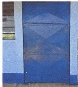
Foto 2: MÓDULO 1 AULAS PUERTAS DE METAL: Mantenimiento a estructura (lijado, cambio de tubo, cepillado, sujeciones, aplicación de pintura); Sustrucción de chapa
