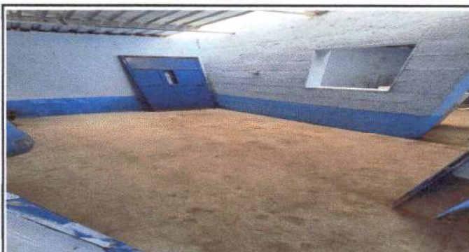
Foto 9: MÓDULO 3 COCINA: PISO: Sustitución de piso de torta de concreto
