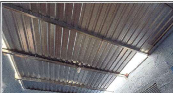
Foto 8: MÓDULO 3 COCINA: ESTRUCTURA DE TECHO: Sustitución de estructura de soporte de metal, por metal
